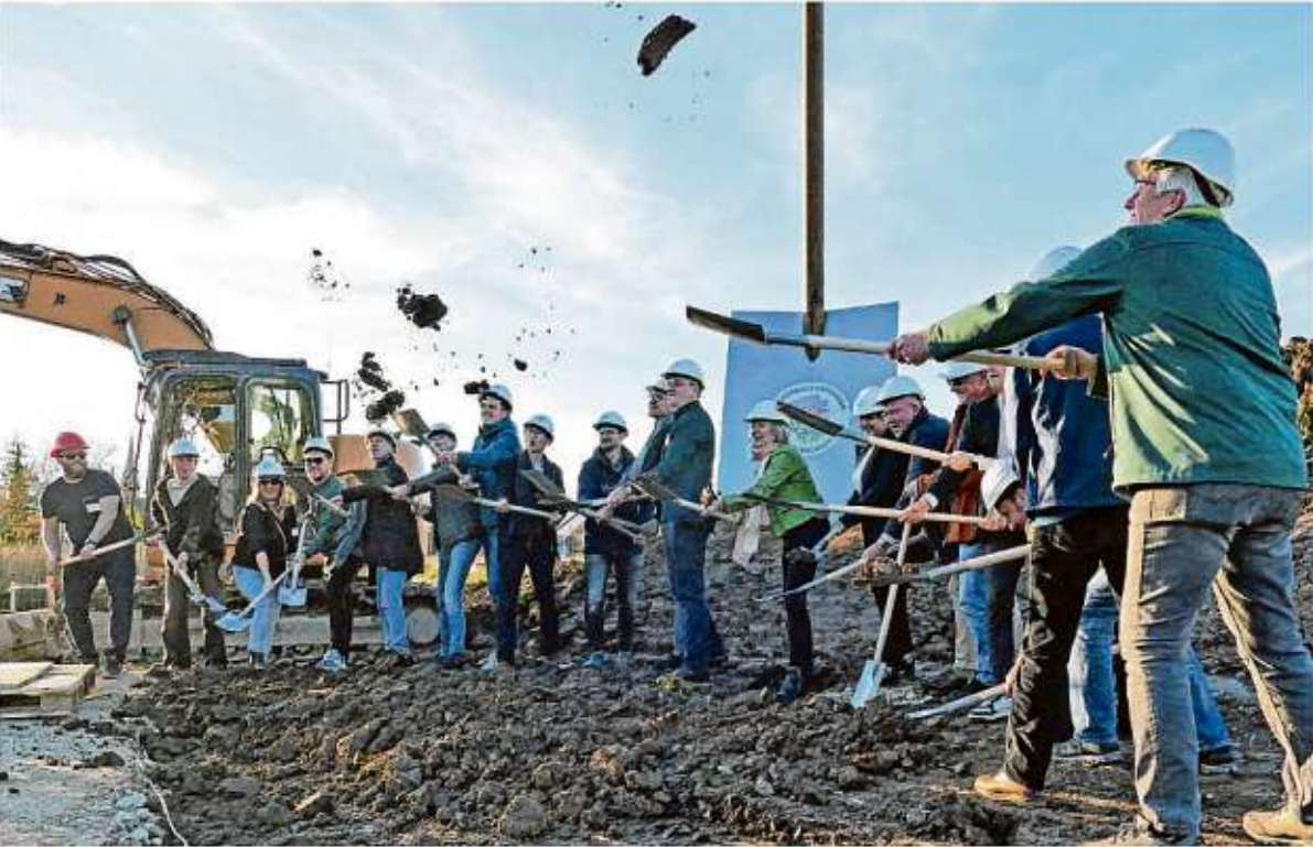
Am Donnerstag war Spatenstich für das erste Gebäude mit Bürgermeisterin Christel Halm (Bildmitte). Los geht es mit dem Keller für die zentrale Wärmeversorgung des Baugebiets. Foto: Stephan Gokeler
